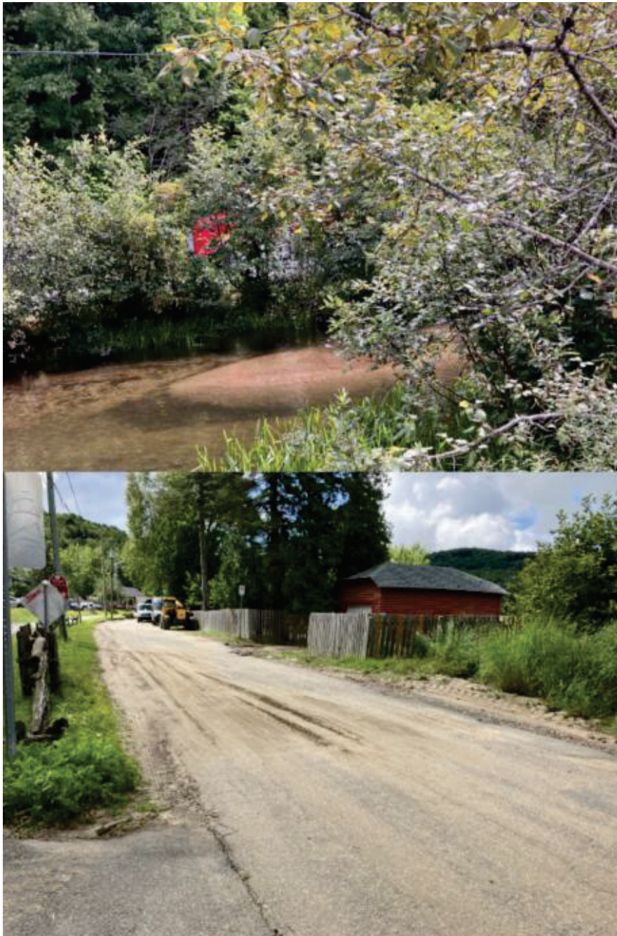
Figure 8 - Accumulations de sédiments au marais filtrant et sur le chemin
