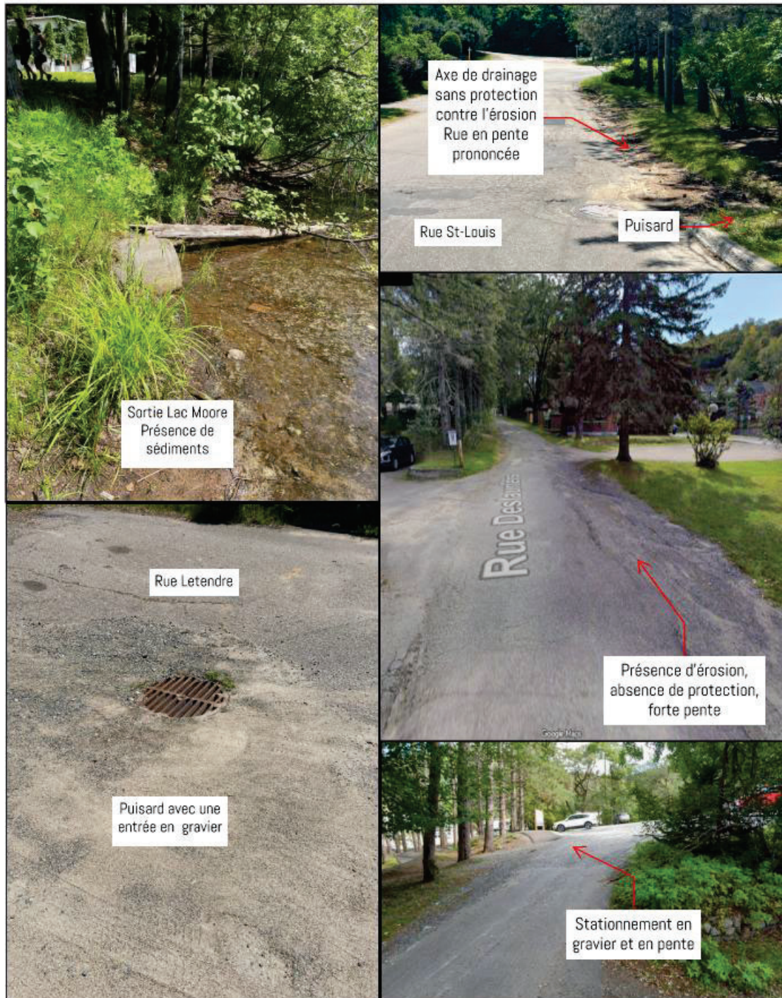
Figure 26 - Sources de sédiments dans le bassin versant
